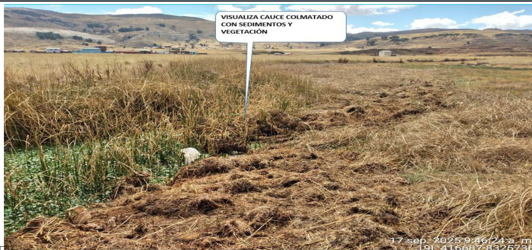
FIGURA 1 : REQUIERE LIMPIEZA Y DESCOLMATACIÓN DE CAUCE EN LA QUEBRADA CUYURAYA TRAMO I, EN EL SECTOR CUYURAYA, DISTRITO DE HUANCANÉ, PROVINCIA DE HUANCANÉ, DEPARTAMENTO DE PUNO.
