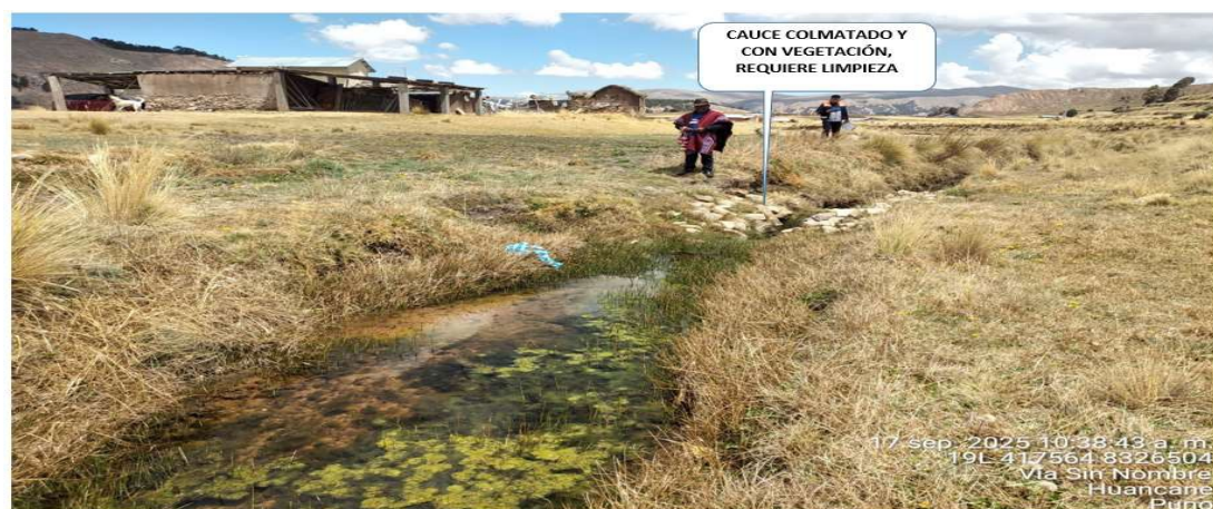
FIGURA N°02: VIEVIDAS EXPUESTAS ANTE UNA CRECIDA DE LA QUEBRADA CUYURAYA TRAMO II, REQUIERE DE LIMPIEZA Y DESCOLMATACIÓN DEL CAUCE.
